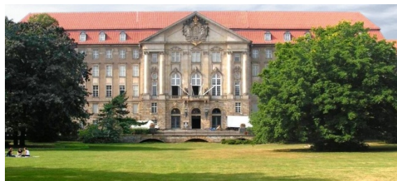
Abb. 23: Kammergerichtsgebäude in Berlin 4
