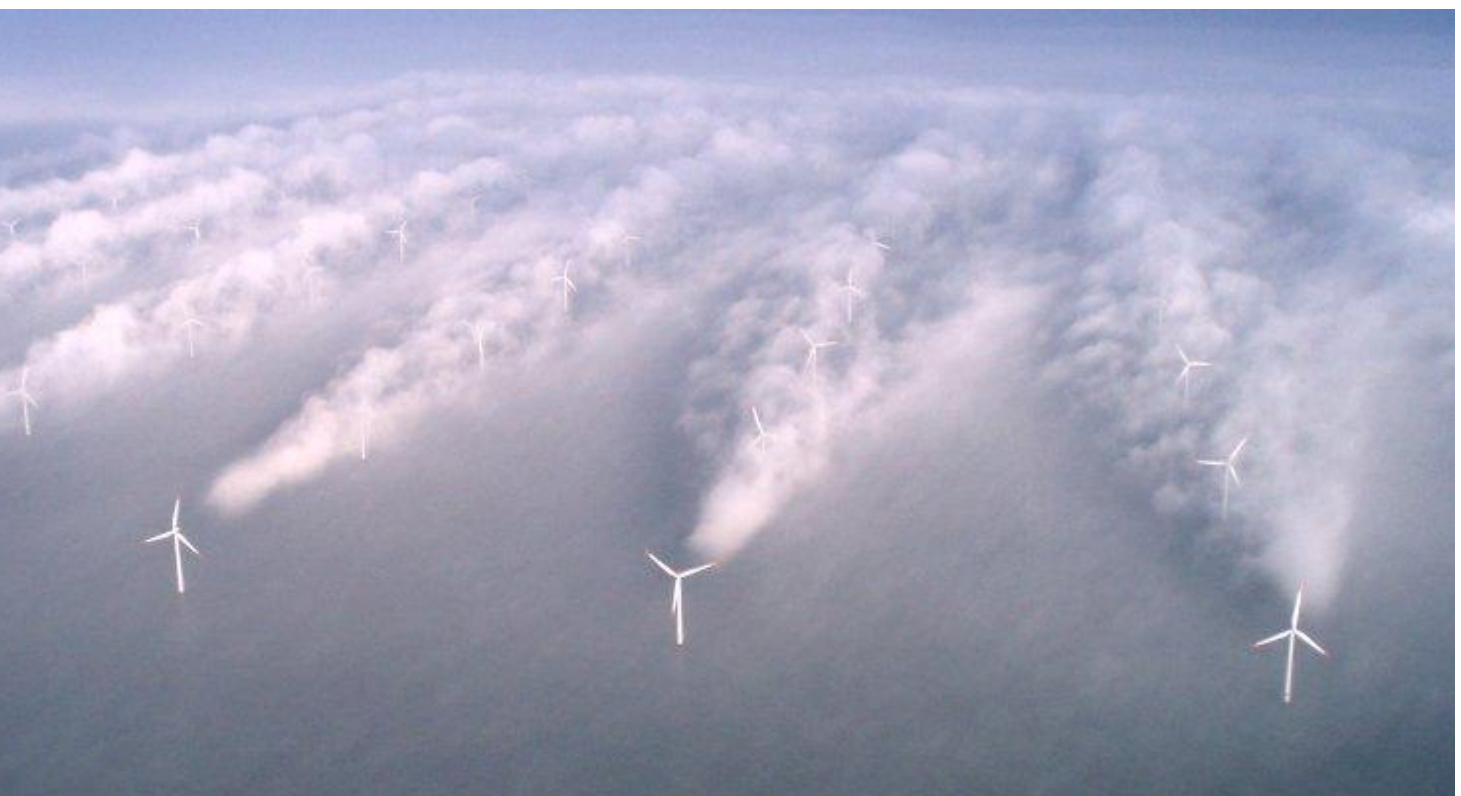
Windpark im Testbetrieb; Foto: Vattenfall
