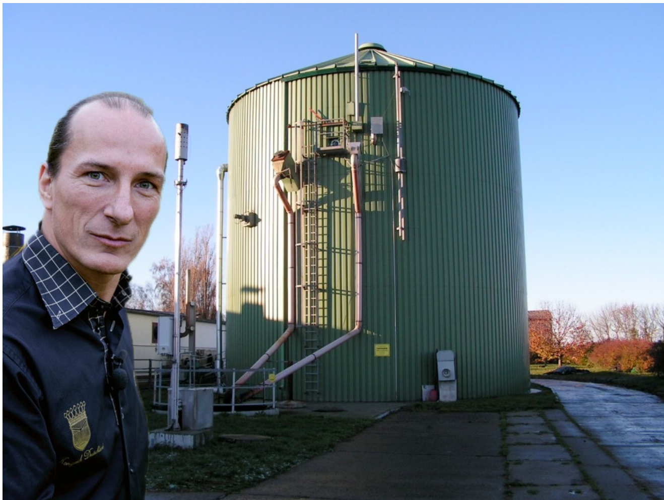
Peter Fitzek stolz vor seiner Biogasanlage
